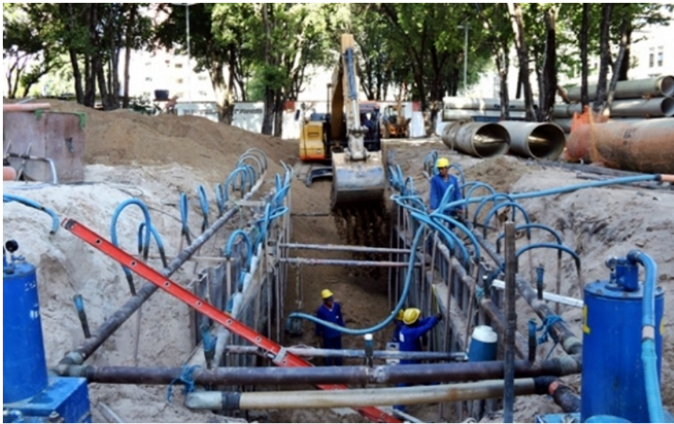
Obra de saneamento básico da Casal, em Maceió.
